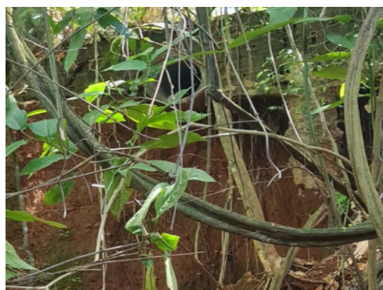
Figura 10 - Lançamento final sem dispositivo de dissipação e transição para o corpo hídrico.
