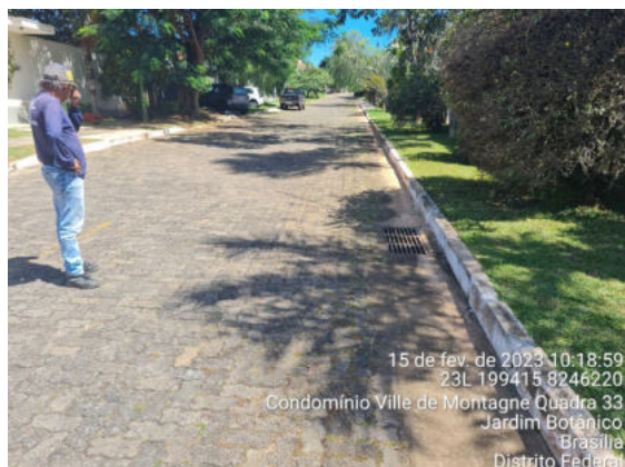
Figura 5 - Captação por boca de lobo do tipo grelha. Rede existente.
