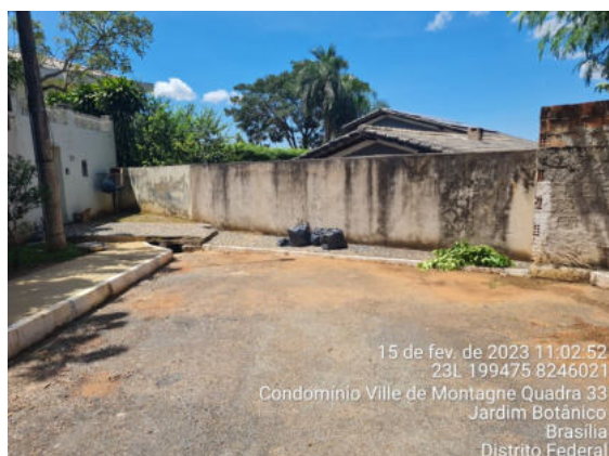
Figura 7 - Boca de lobo e muro de divisa ao fundo do lote da Sr. Claudia.
